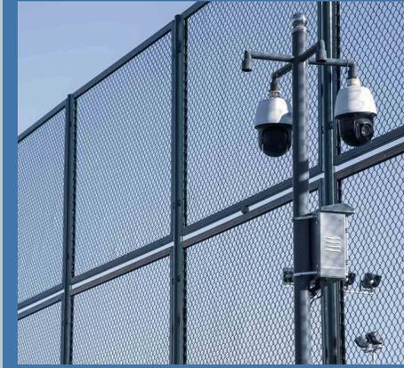
**Schiavo Costruzioni S.r.l.** con un'esperienza pluriennale nel settore dell'edilizia ci ha scelto per realizzare un impianto VSS nella nuova sede. Il progetto ha previsto un sistema di videosorveglianza perimetrale di 500 mt realizzato con armadi collegati in fibra ottica e Camere IP PoE con I.A. integrate poi con un sistema allarme AVS che gestisce le telecamere come zone attive per l'Intrusion Detection (IDS)
